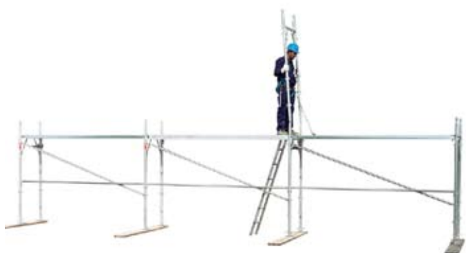
27 • montáž rámu podlažia 1
