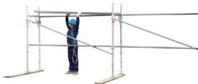
16 • montáž kovových dosiek
