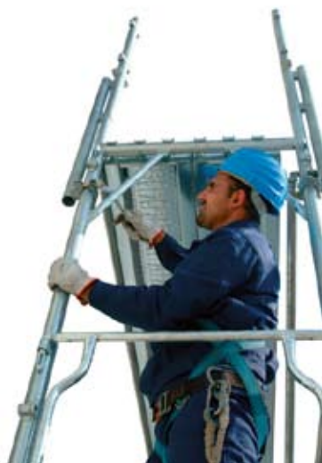
49 • utiahnutie spoja vrcholového stojanu na podlaží 2
