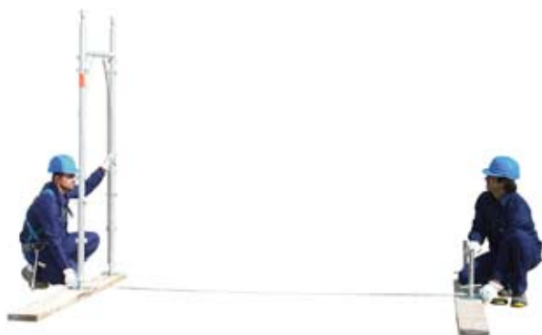
3 • úprava podložiek do vodováhy
