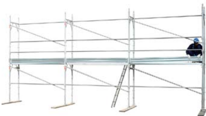
39 • montáž zábran na podlaží 1
