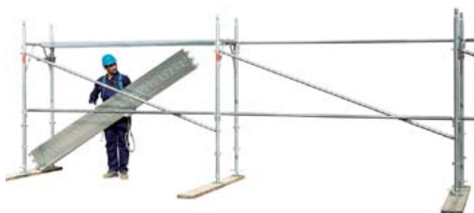
17 • montáž kovových dosiek
