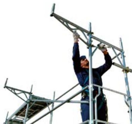
59 • montáž konzoly so vzperou
