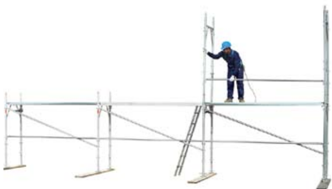
31 • montáž pozdĺžnej tyče na podlaží 1
