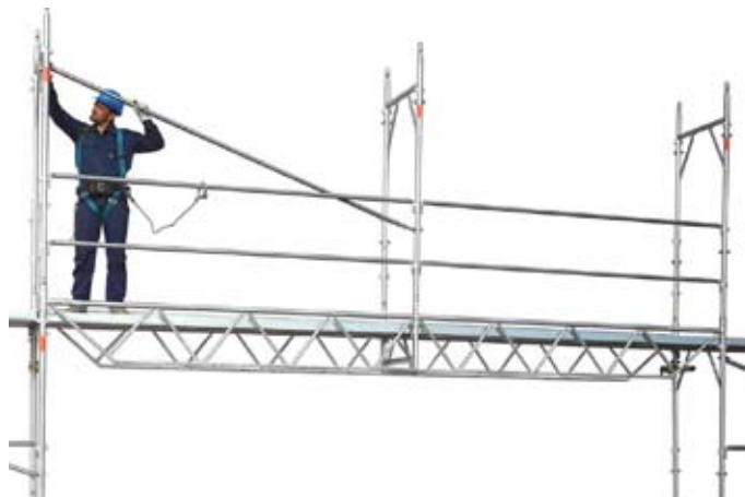
70 • montáž predných priecok nad "prejazdovými" nosníkmi
