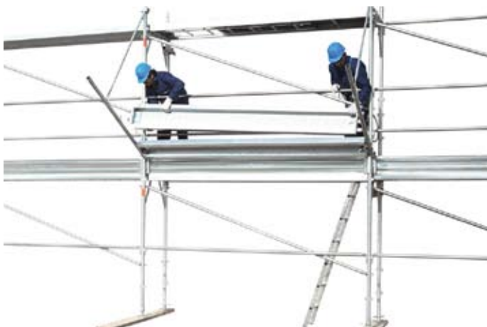
57 • montáž dosiek "protikamenových" zábran
