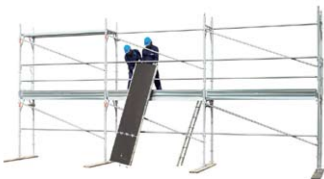
45 • montáž dosiek s prielezom na podlaží 2
