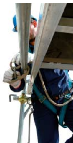
24 • pripojenie prídržného lana pred výstupom na podlažie
