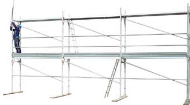
48 • montáž vrcholového stojanu na podlaží 2
