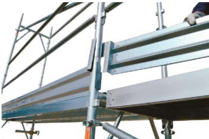
37 • detail zábran na podlaží 1
