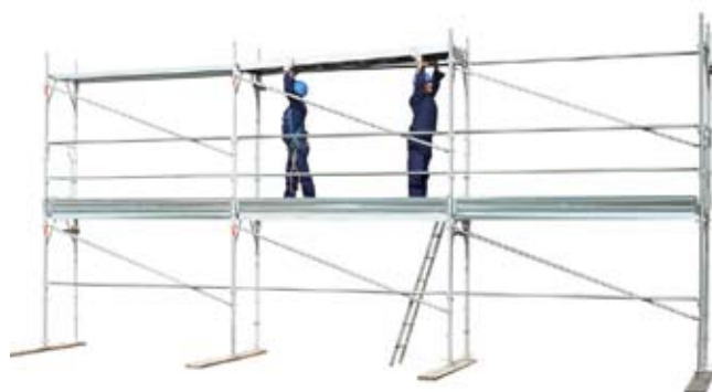
46 • montáž dosiek s prielezom na podlaží 2
