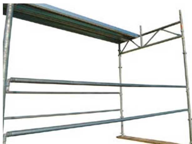
65 • montáž dosiek na rám prechodu pre chodcov
