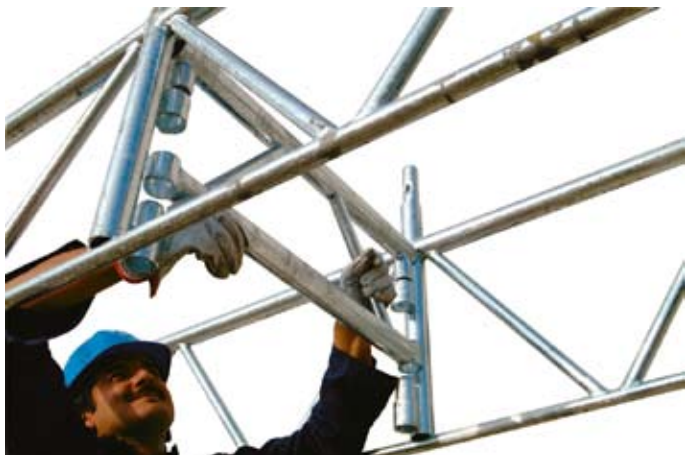
67 • montáž spojovacieho trámu "prejazdových" nosníkov
