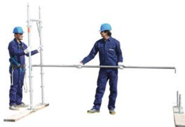
4 • založenie pozdĺžnej tyče
