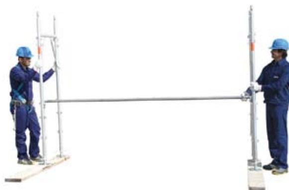
5 • montáž druhého rámu s parapetom
