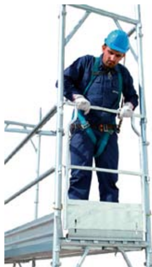
41 • montáž celného parapetu na podlaží 1
