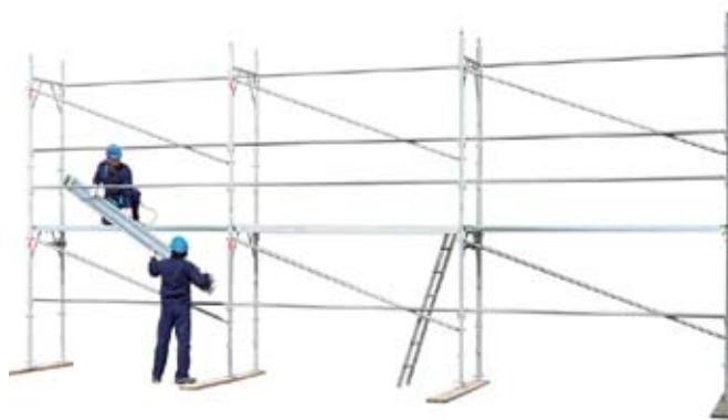
36 • montáž zábran na podlaží 1
