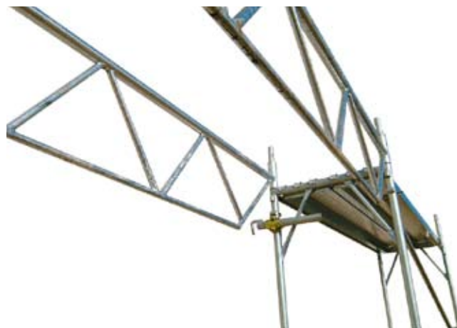
66 • montáž "prejazdového" nosníka
