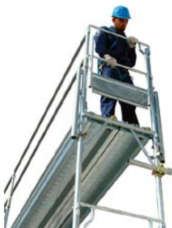
52 • montáž celného parapetu podlažia 2
