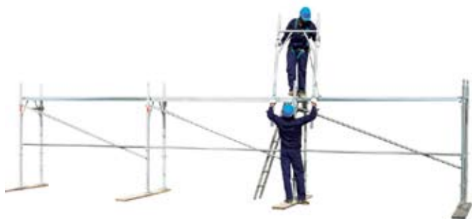
26 • začiatok montáže rámov podlažia 1
