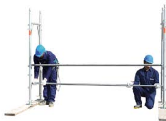
6 • montáž druhej pozdĺžnej tyče
