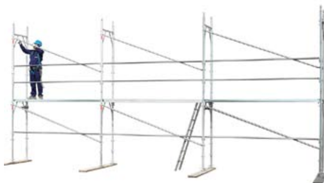
34 • montáž ďalších modulov na podlaží 1
