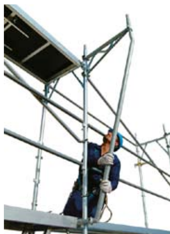
60 • montáž vzpery konzoly
