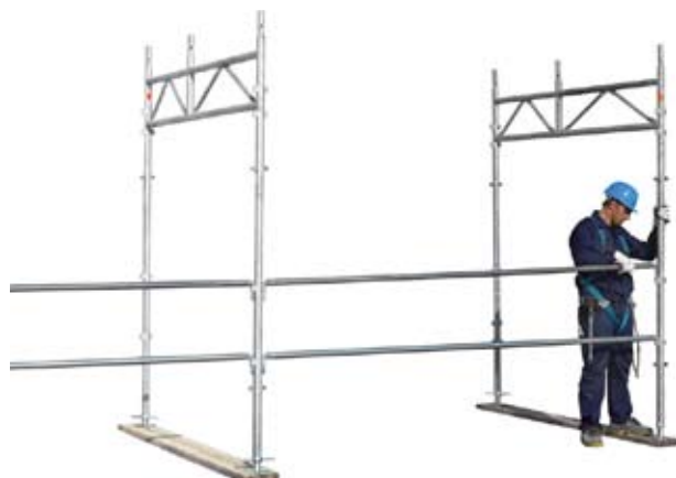
64 • montáž prepojení rámu prechodu pre chodcov
