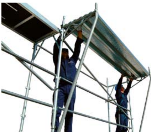
63 • montáž dosiek na konzolu
