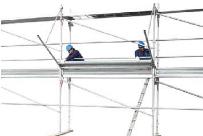
56 • montáž dosiek "protikamenových" zábran
