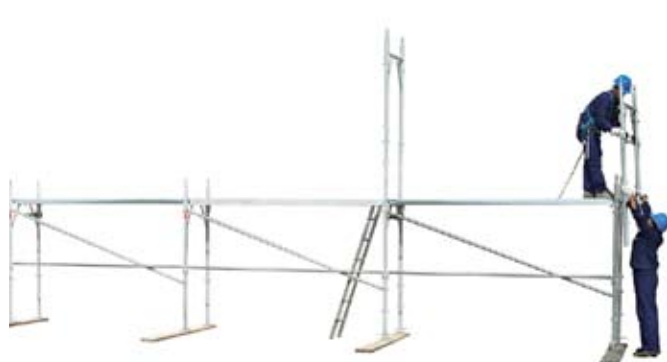
28 • montáž rámu podlažia 1
