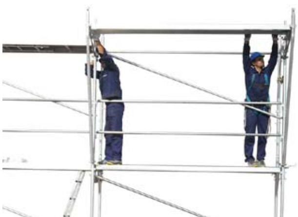
62 • montáž dosiek na konzolu
